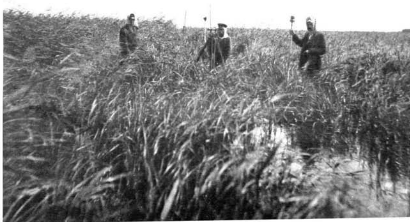
Работы по осушению Барабинской степи. Нивелировка.
