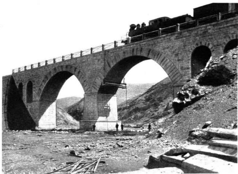
Арочный каменный мостъ, длиной 20 саж., черезъ р. Кинчжоо на Китайской Восточной жел. дор.
