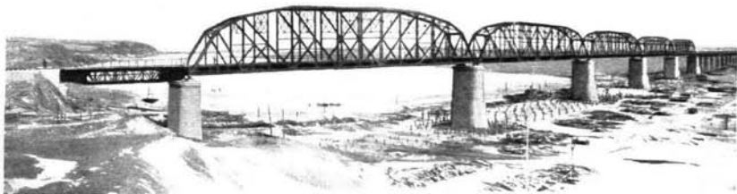
Мостъ черезъ р. Сунгари I, длиной 445 саж., на Китайской Восточной жел. дор. (8 пролетовъ по 35 саж. и 11 пролетовъ по 15 саж).
